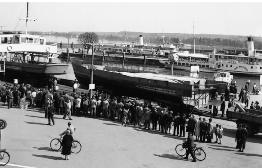
Konstanz. Die zwei Schalenteile der «Ville-d'Estavayer» werden aus der Fähre Schussen ausgeladen für die Weiterfahrt auf der Strasse nach Nidau. Im Hintergrund die Dampfschiffe Stadt Überlingen und Stadt Meersburg. (Foto R. LeRoy, 2. Februar 1961)
